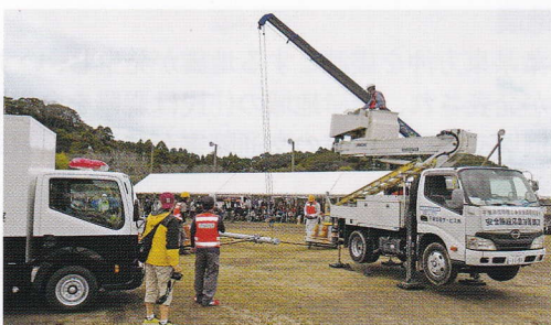
ライフライン復旧訓練
