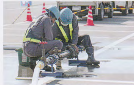
水道復旧訓練
