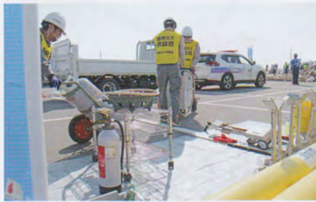
ガス復旧訓練
