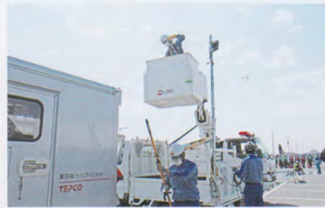
電力復旧訓練
