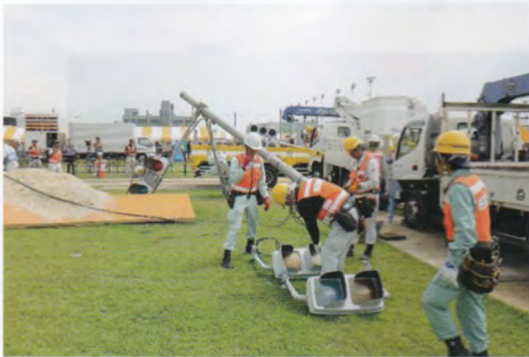
主会場：倒壊信号機撤去訓練
