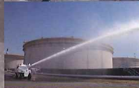
放水砲ロボット ウォーター・キャノン
